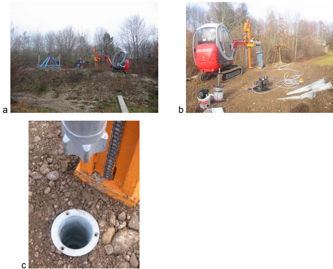
Abb. A9-6a bis c: Versuche auf dem Gelände „ehemaliger Schießplatz“ der UniBwM in Neubiberg, Halde aus lokalem Kies einer vorangegangenen Baumaßnahme (Standort „UniHl“) mit Eindrehgerät, Prüfeinrichtung (a), Densitometer, leichter Rammsonde, SF (b) und frisch in den Boden eingedrehtem SF
